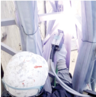
低電圧低温アーク溶射工法
