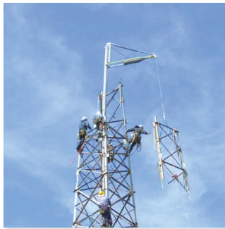
簡易フロート型鉄塔組立装置
