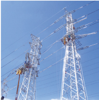
太径1520mm既設電線の移線工法
