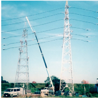
ケーブルジャンパ工法(CJ工法)
