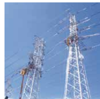
太径1520mm既設電線の移線工法
