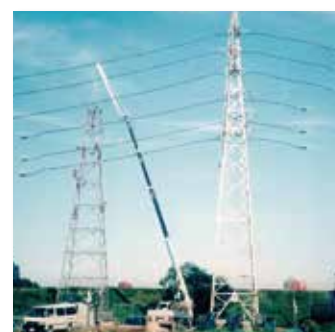
ケーブルジャンパ工法 (CJ工法)
