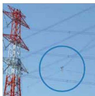
スライド移線工法
