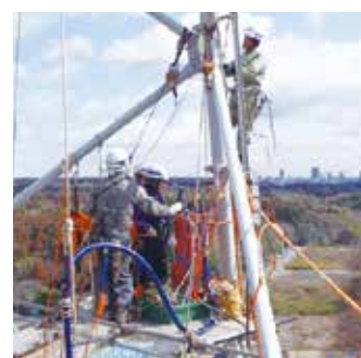
内面塗装工法
