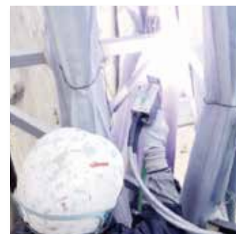
低電圧低温アーク溶射工法
