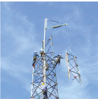
簡易フロート型鉄塔組立装置
