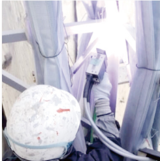
低電圧低温アーク溶射工法
