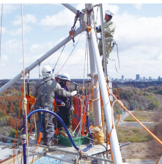
内面塗装工法
