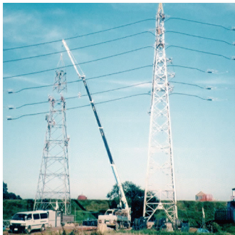
ケーブルジャンパ工法(CJ工法)
