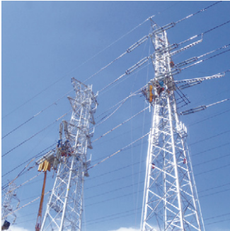
太径1520mm既設電線の移線工法
