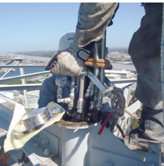
発泡ウレタン充填工法
