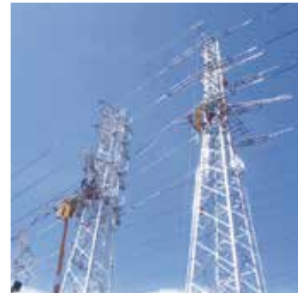
太径1520mm既設電線の移線工法
