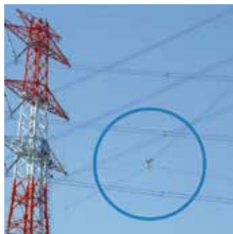
スライド移線工法
