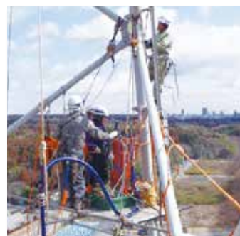
内面塗装工法
