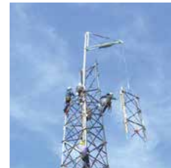
簡易フロート型鉄塔組立装置
