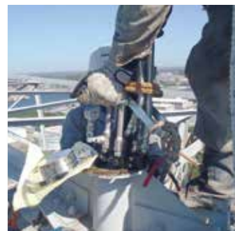
発泡ウレタン充填工法
