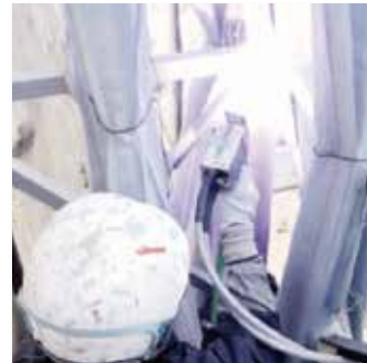
低電圧低温アーク溶射工法
