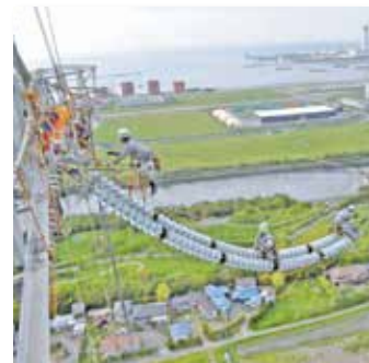
一括緊線解体によるがいし装置取替工法
