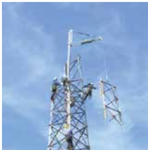
簡易フロート型鉄塔組立装置
