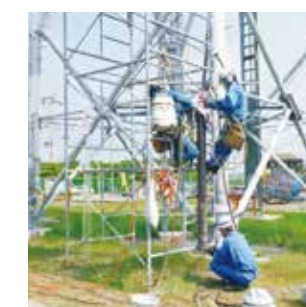
内面塗装工法
