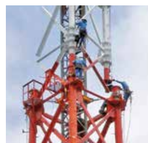
鉄塔組立工事
