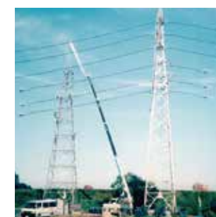
ケーブルジャンパ工法(CJ工法)
