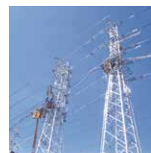
太径1520mm既設電線の移線工法
