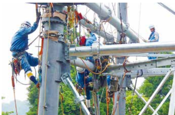
鉄塔部材交換
