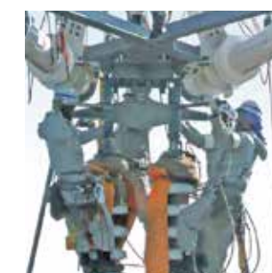
送電用がいし装置の 支持ボルト等の取替工法
