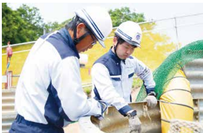
鉄塔基礎工事
